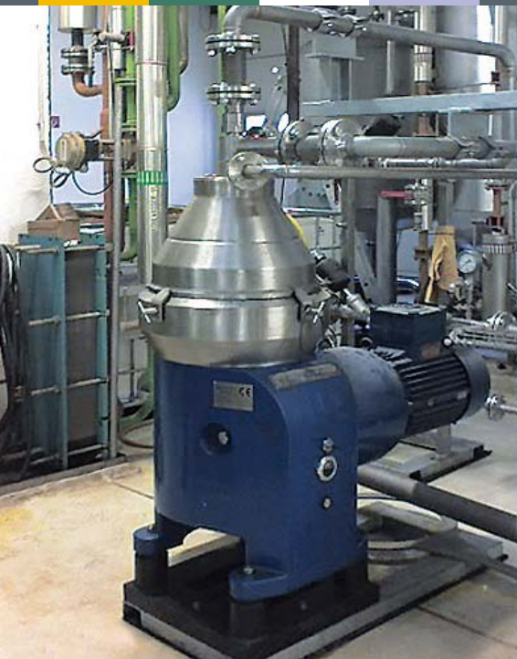
Raffinazione oli di cottura usati Used cooking oil refinery
